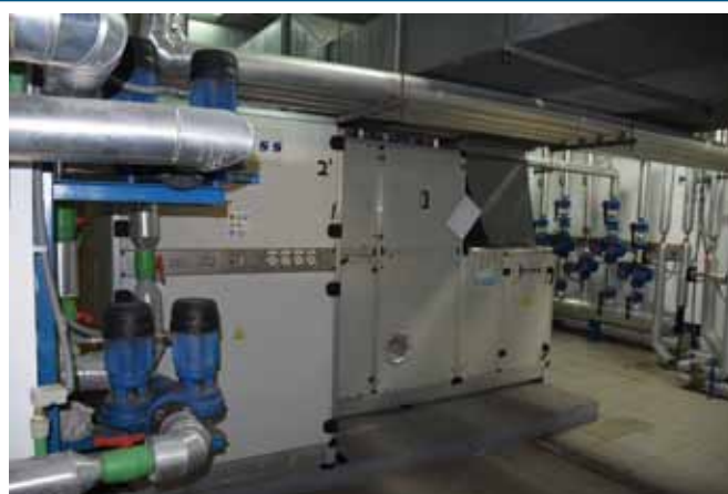
Figura 9. Esquema del sistema de climatización de las piscinas e imagen de una de las máquinas climatizadoras.
